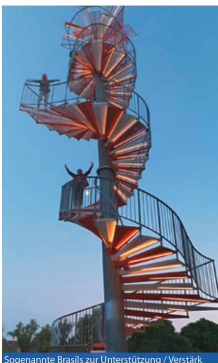
Sogenannte Brazils zur Unterstützung / Verstärk
